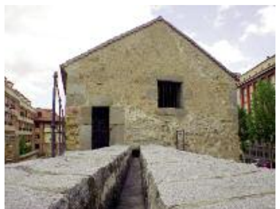
Nacimiento del Acueducto y Canal del Acueducto y desarenador
